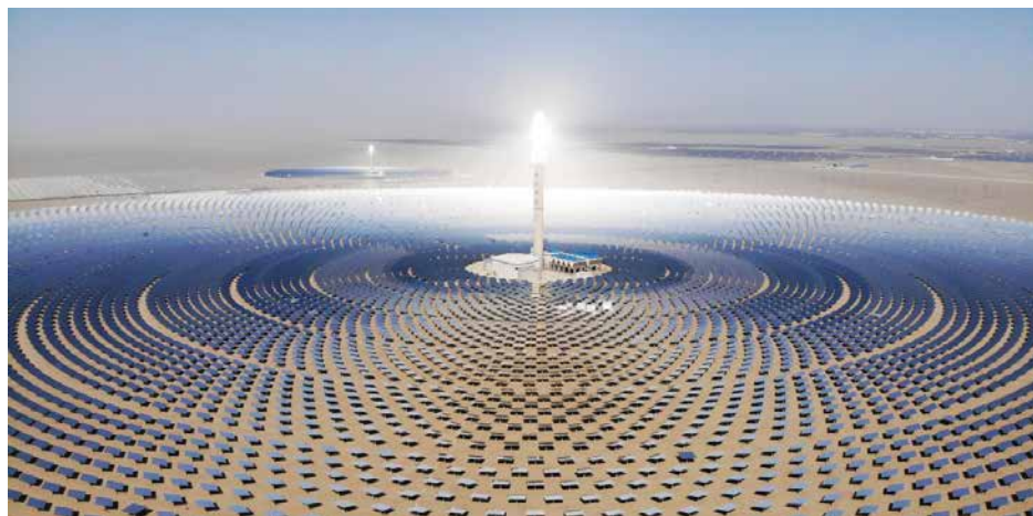
图 5-1-6 敦煌首航 10+100MW 光热电站
