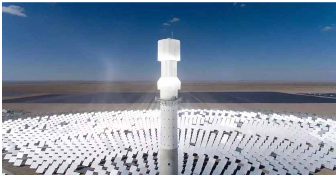
图 5-1-4 鲁能海西州 50MW 光热发电项目
