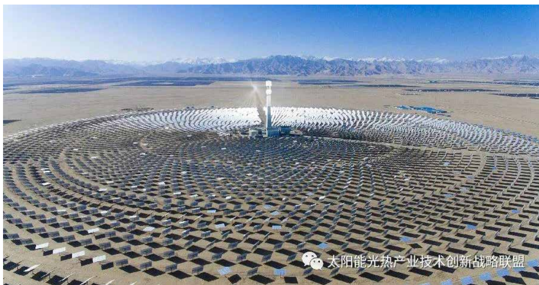
图 0-2 鲁能海西格尔木 50MW 塔式光热电站
